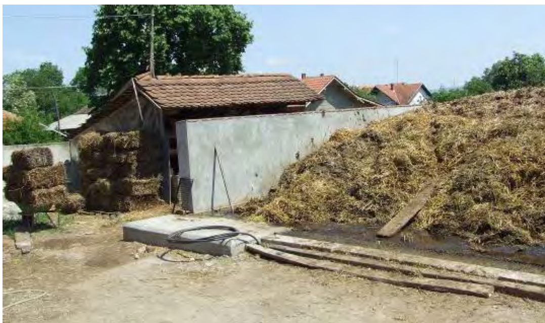
Слика 38 – Бетонски плато за прихват отпада из фарме
