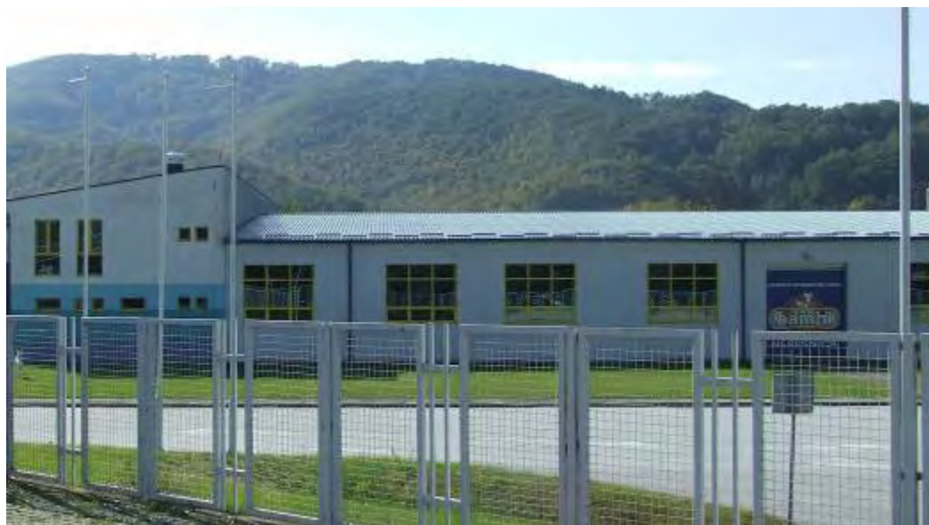
Слика 13 - Фабрика воде Дубока - Нересница
