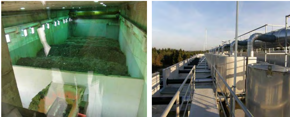
Слика 47. Постројење за МБО у Цељу, Словенија - капацитет 350.000 ЕС (горе) - унутрашњост коморе за обраду отпада (лево) и филтери за пречишћавање ваздуха (десно)
